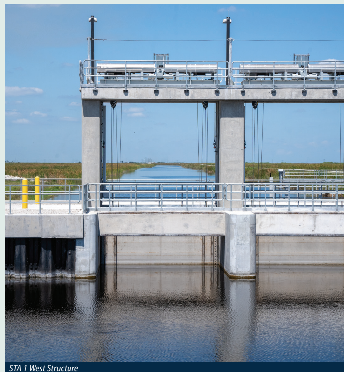
STA 1 West Structure
