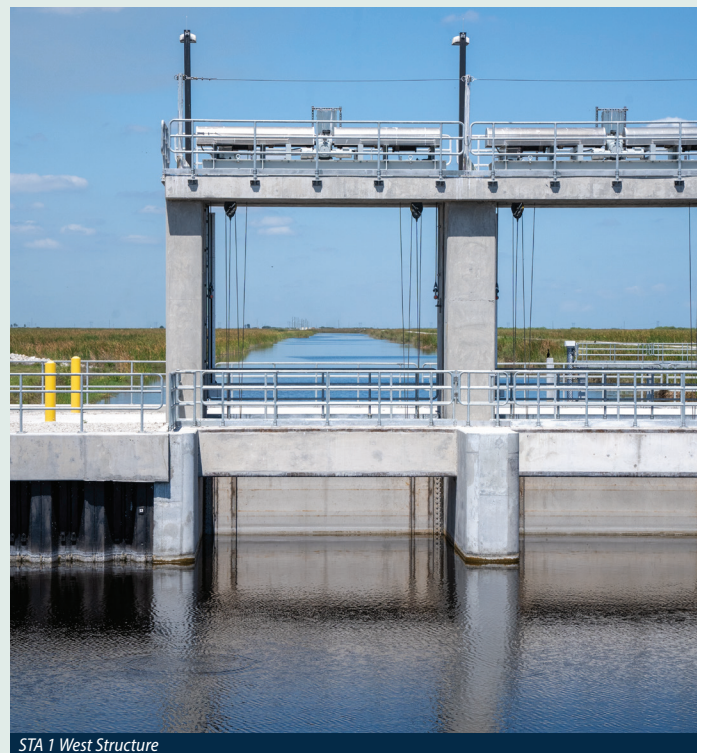
STA 1 West Structure
