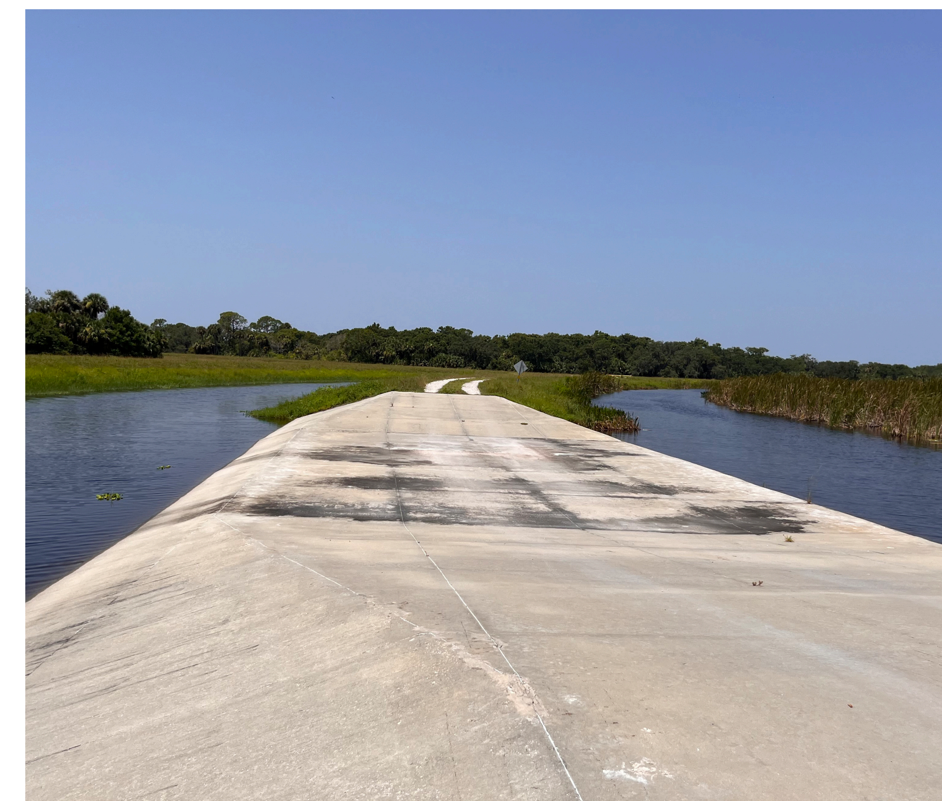
STA Overflow Weir
